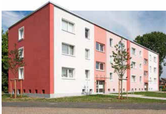
Frisch gedämmt: Häuser in der Kamp-Lintforter Rundstraße
