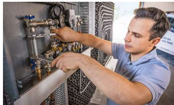
Idriz Cerkini sammelt Erfahrung an neu installierten Geräten
