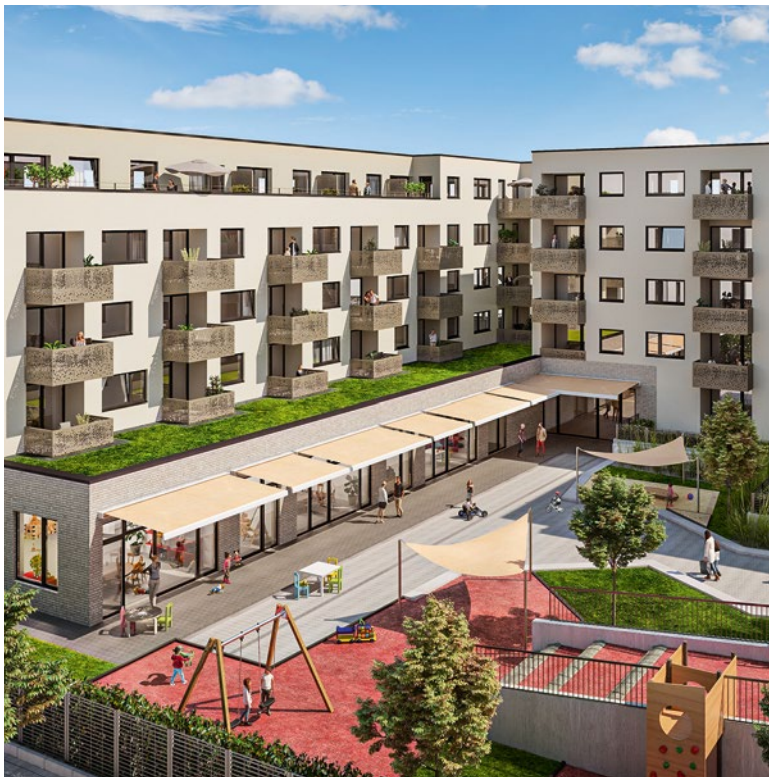
Der Kindergarten im Düsseldorfer Quartier Schöffenhöfe wurde von VIVAWEST gebaut
