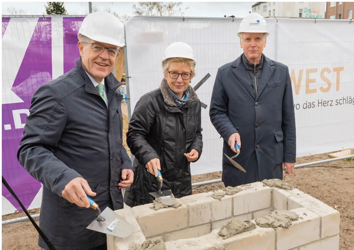
Legten symbolisch den Grundstein: Hans Wilhelm Reiners, Oberbürgermeister der Stadt Mönchengladbach, Claudia Goldenfeld, Sprecherin der VIVAWEST-Geschäftsführung, und Burkhard Schrammen, Geschäftsführer der Schrammen Architekten BDA (von links)
