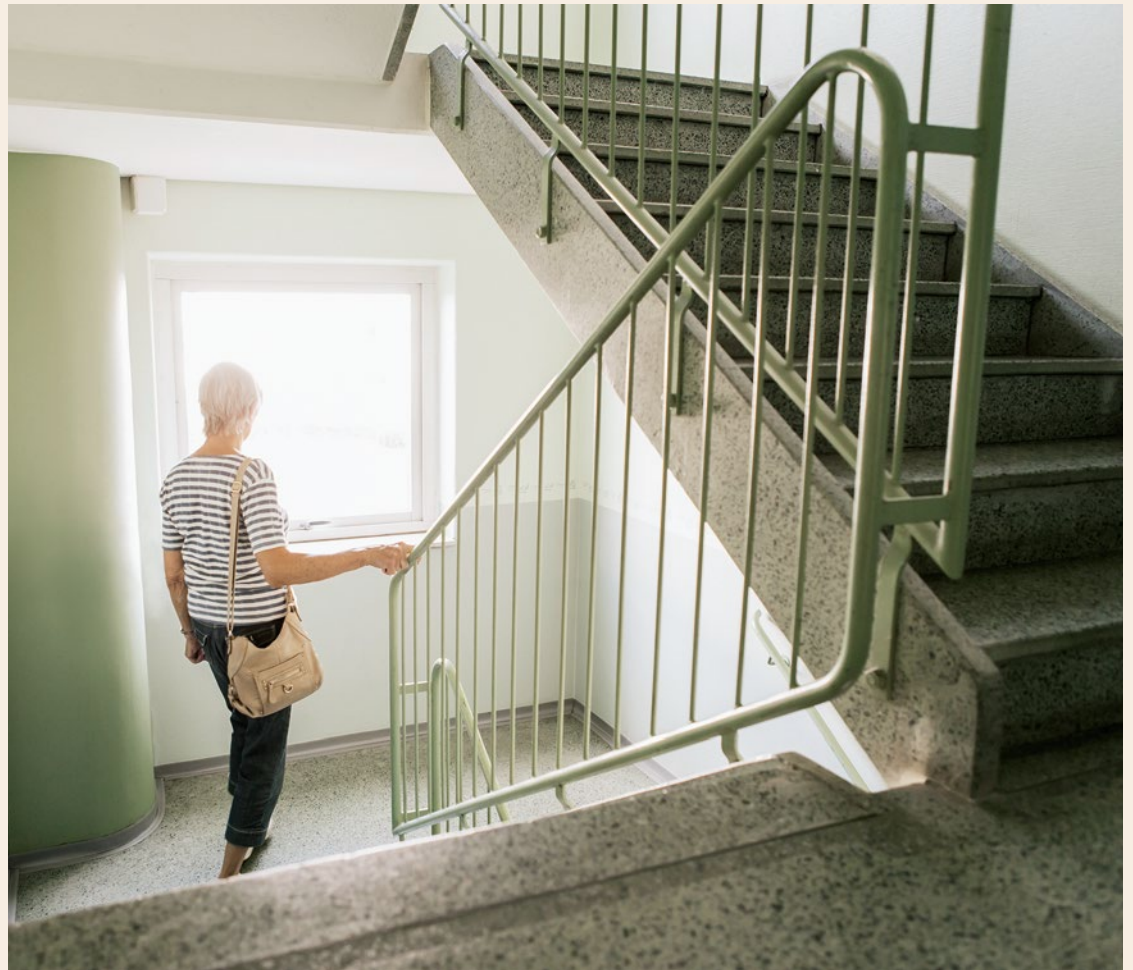
Das Treppenhaus sollte frei von Hindernissen sein und nicht als Abstellkammer genutzt werden
